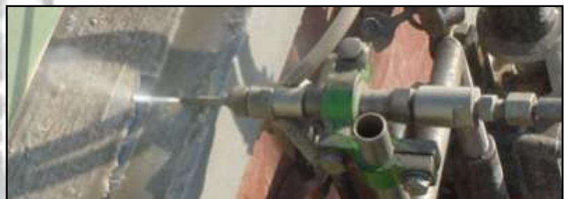
Photo ci-dessus : Détail de la séparation d'une calotte de réservoir.
