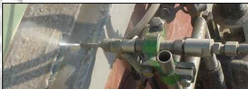
Foto boven: Detail van het lossnijden van een tankdak.
